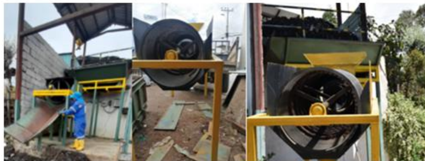
Figura N°77: Mantenimiento de la estructura de la tamizadora
