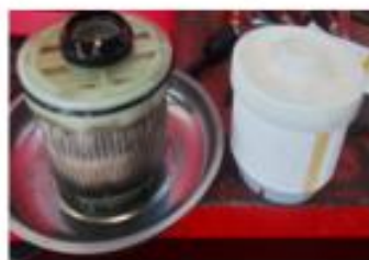
Figura N°6: Cambio de filtros de combustible
