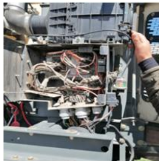
Figura N°48: Limpieza de caja de componentes eléctricos
