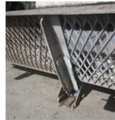
Figura N°57: Arreglo del estribo posterior
