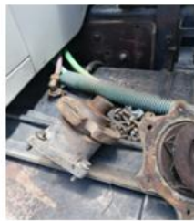
Figura N°26: Cambio de bomba de agua
