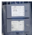
Figura N°24: Cambio del módulo control del refrigerante
